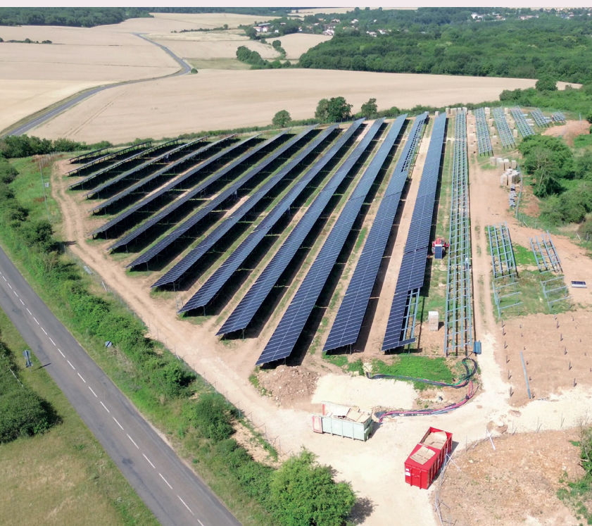
Parc photovoltaïque de Pouzioux Solaire (en phase chantier)
